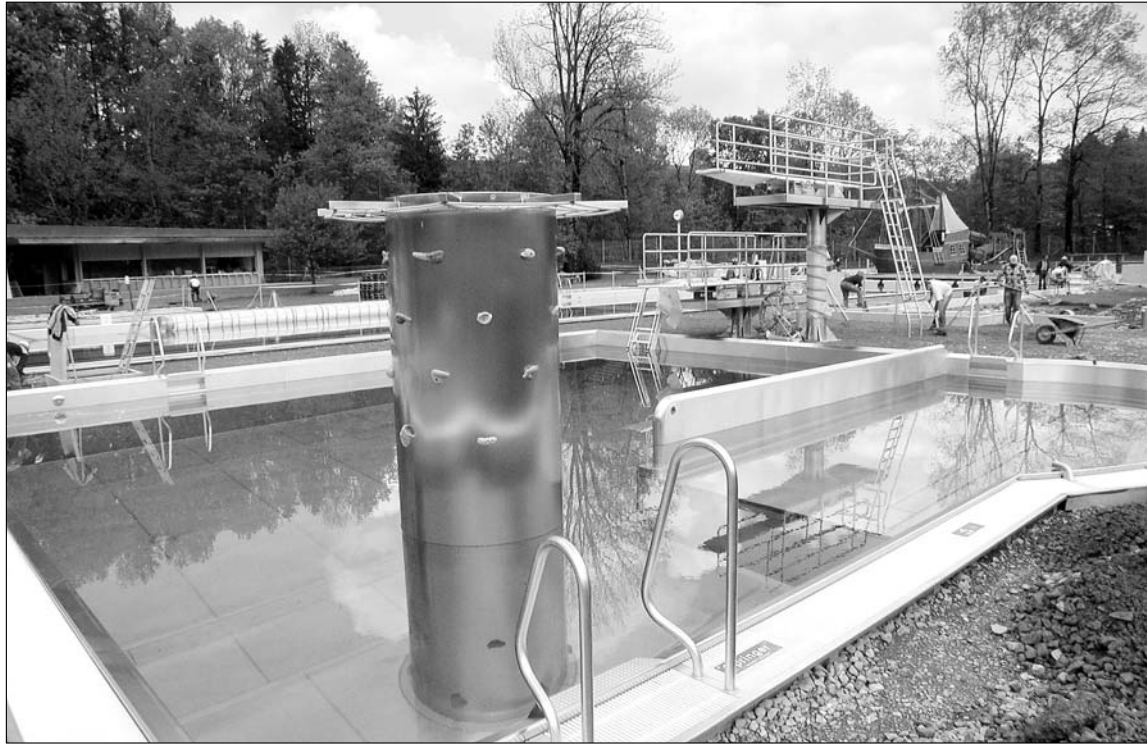
Sämtliche Becken der Forrenbadi sind neu gebaut und wurden in Chromstahl ausgekleidet. Kletterturm und Sprunganlage mit Tiefbecken sollen besonders jugendliche und sportlich Ambitionierte anlocken. Das Hauptbecken lässt sich mittels hydraulischer Trennwand unterteilen. (Bild: Rolf Rechsteiner)
