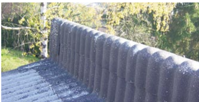
Faserzementwellplatten gereinigt
