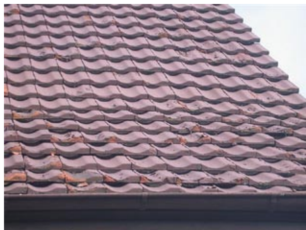
Schadhafte Beschichtung
